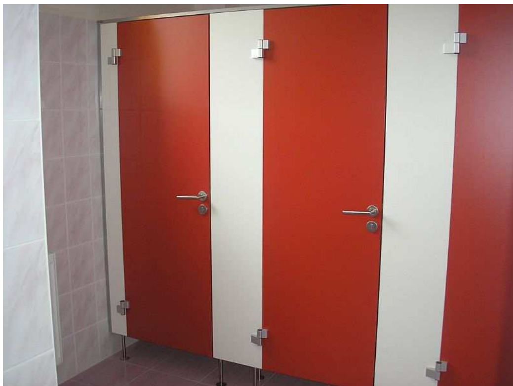
Sociální zařízení po rekonstrukci
