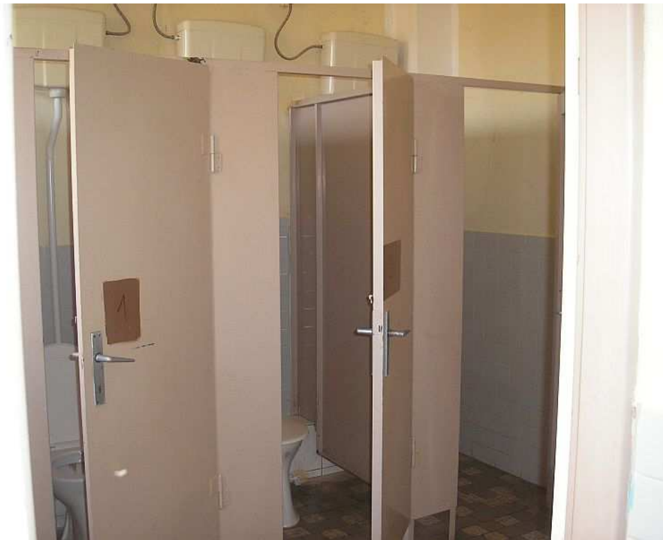
Sociální zařízení před rekonstrukcí
